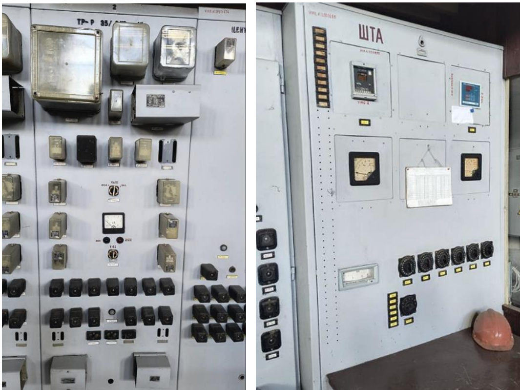
Рисунок 3-2 Застарілі шафи контролю та управління
