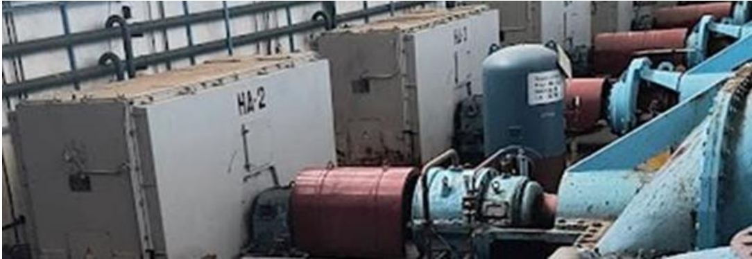
Рисунок 3-5 Старий насосний агрегат з підшипниками ковзання
